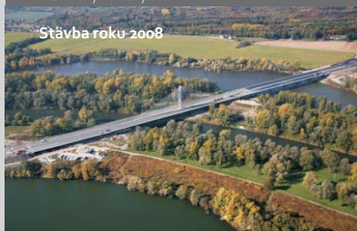
Zavěšený most na D47 přes řeku Odru
